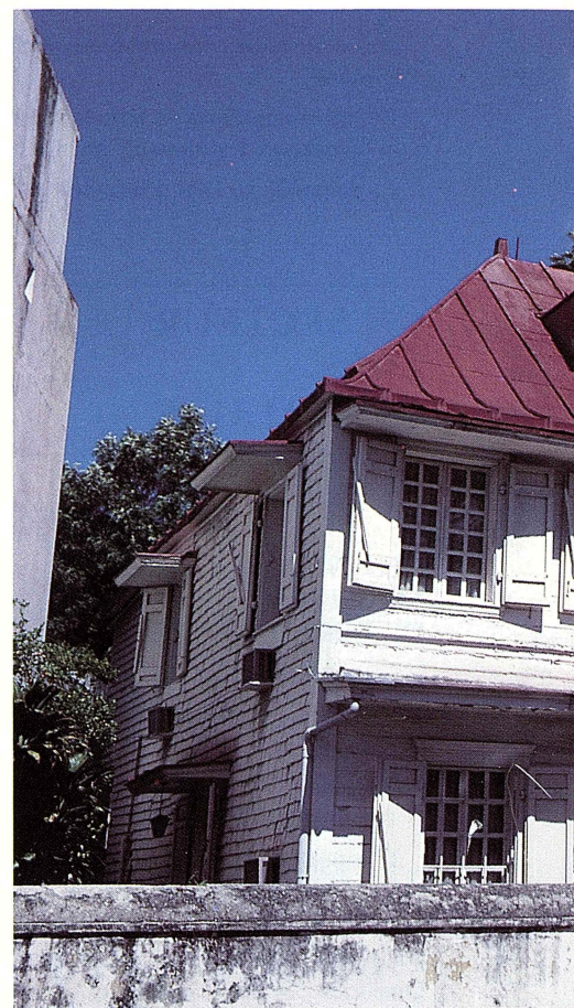
Une case créole ancienne, à ossature bois.
