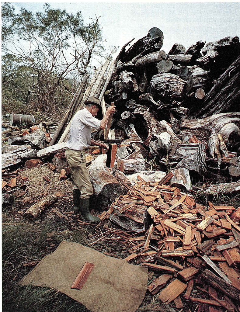
Fabrication traditionnelle de bardeaux de tamarin.
