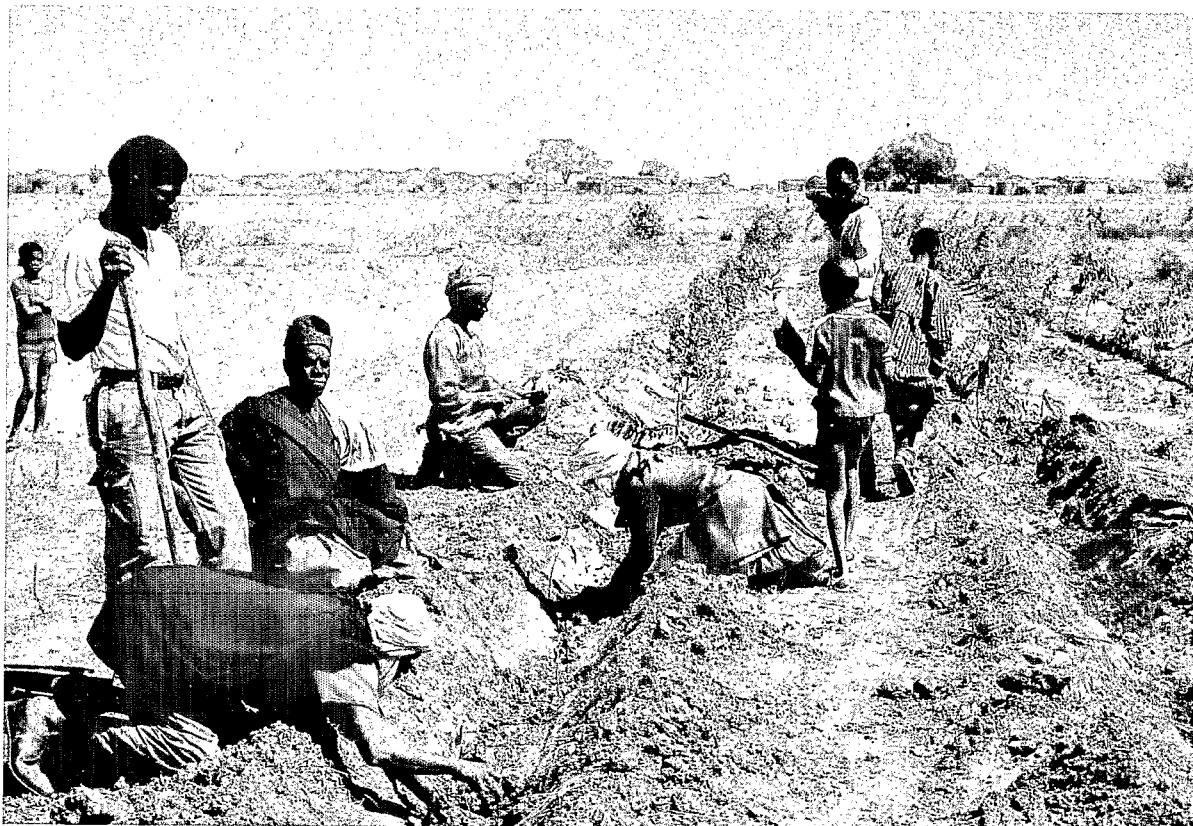
Plantation d'une bande brise-vent par les paysans autour de leur périmètre irrigué. Doué.
