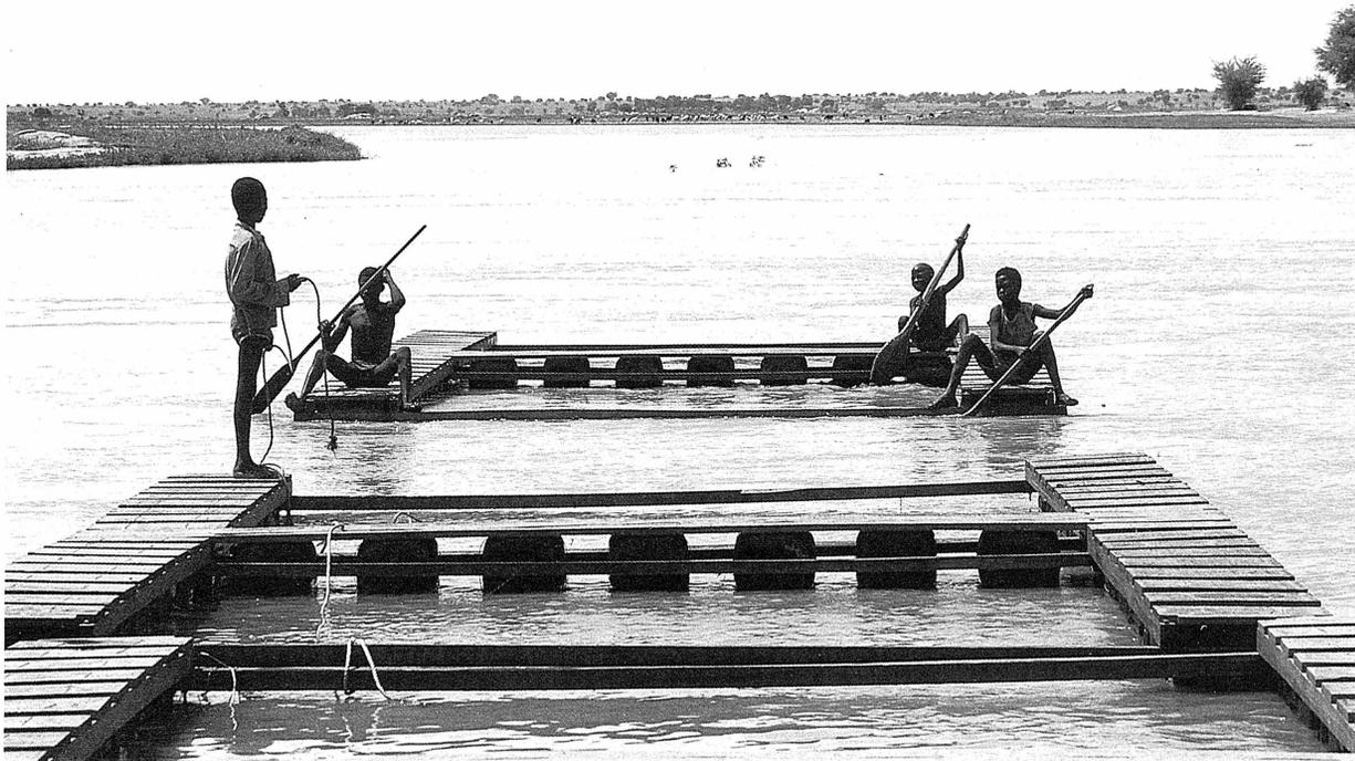
Mise en place des pontons flottants sur le Fleuve Niger (chaque ponton supporte 2 cages de 20 m<sup>3</sup> ou 8 cages de 5 m<sup>3</sup>).
