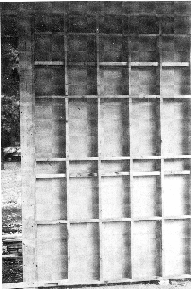
PHOTO n° 4. Système de construction traditionnel. On distingue sur la photo l'ossature composée des montants et des traverses et le revêtement extérieur.
