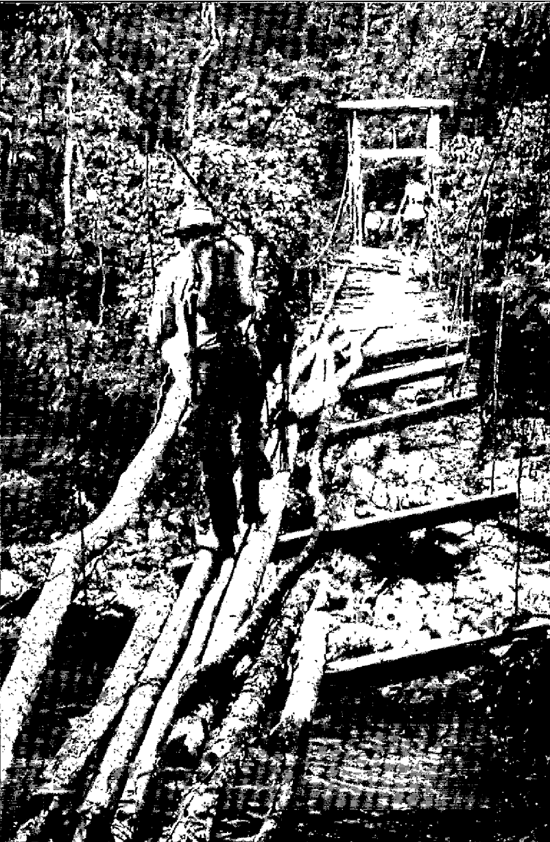
Inventaire en Équateur. Traversée du Rio Numbala sur un pont en mauvais état.
