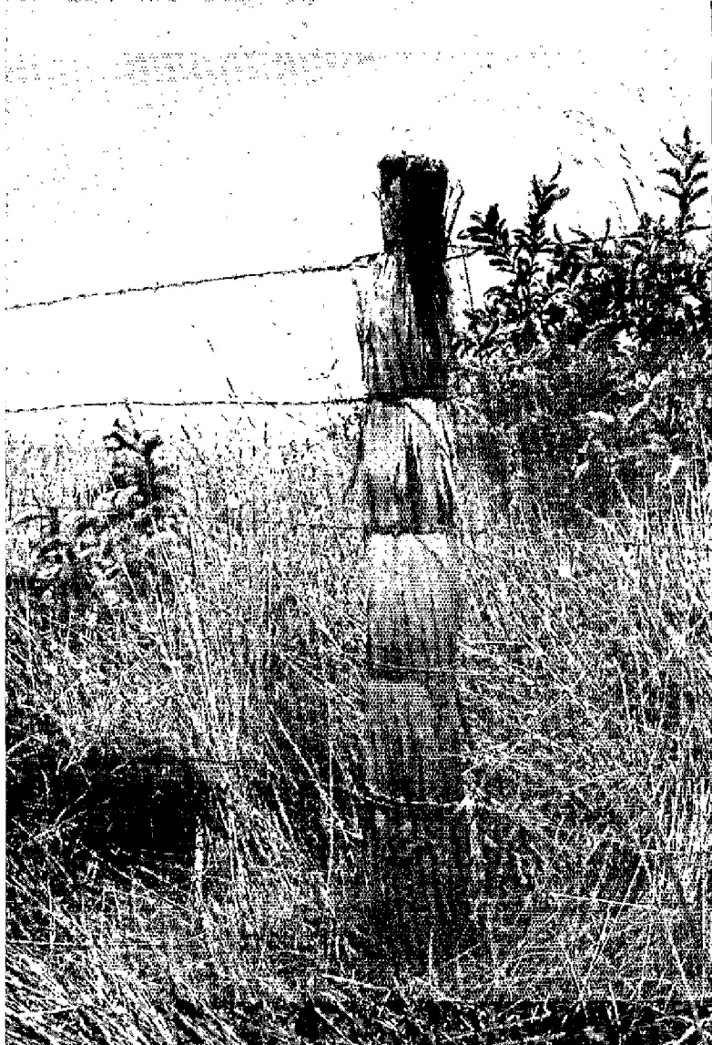
Région du Moyen Ouest. Piquet d' Eucalyptus robusta non traité après 3 ans de service : attaque de termites.
