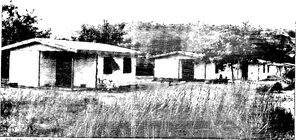
République Centrafricaine. Lotissement du quartier Ouango. Réalisation de la Direction de l'Urbanisme et de l'Habitat.
