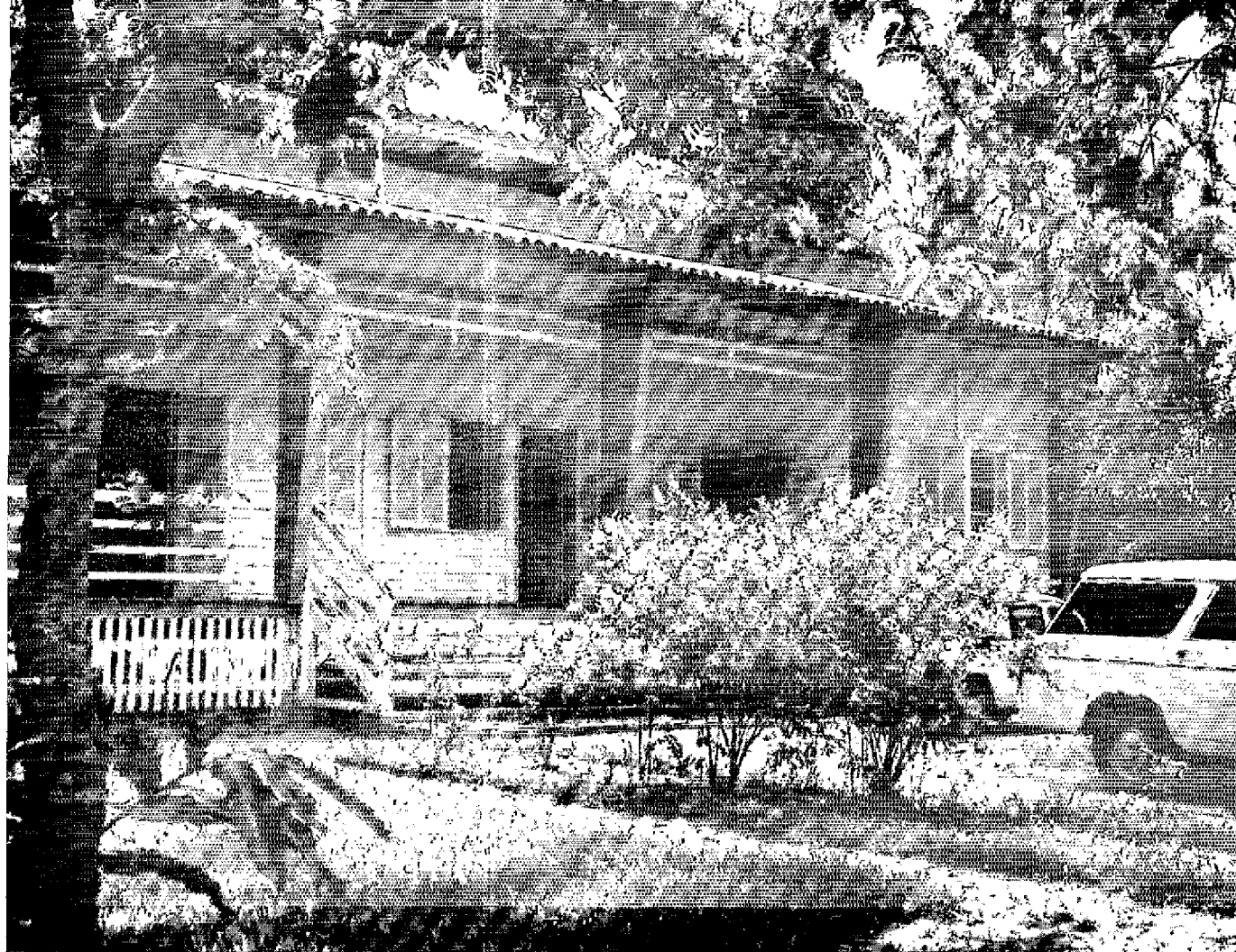
Pointe-Noire. Maison du Service des Eaux et Forêts
