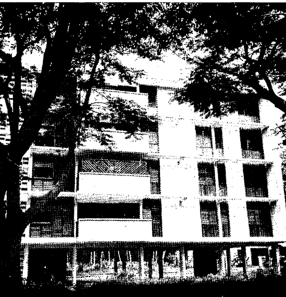
République populaire du Congo. A Brazzaville, l'immeuble dit des 32 logements.
