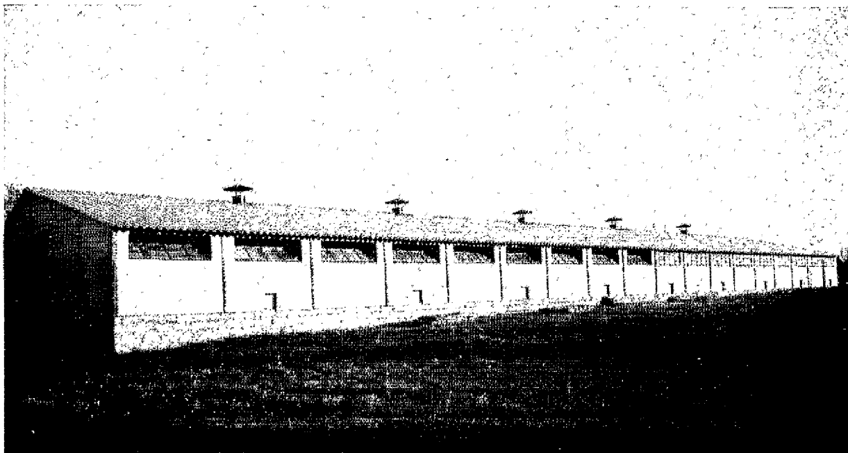
Murs de poulailler en contreplaqué extérieur.
