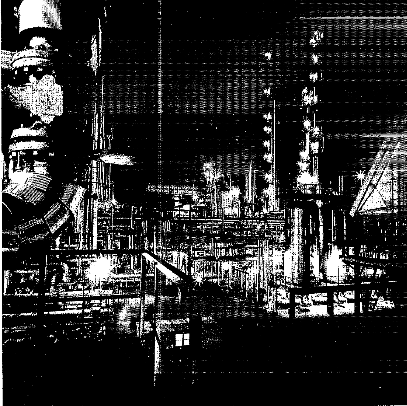
Unité de Steam cracking à la raffinerie de Port-Jérôme.
