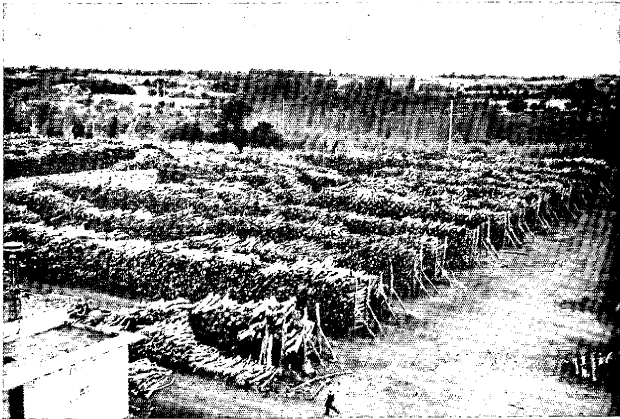
Usine PAMER — Parc à bois.
