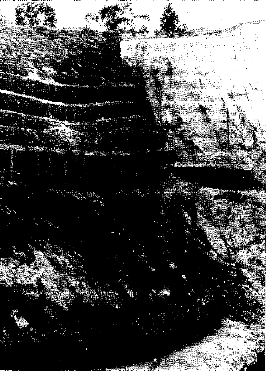
Correction de lavaka, PK 111. Route du lac Alaotra.
