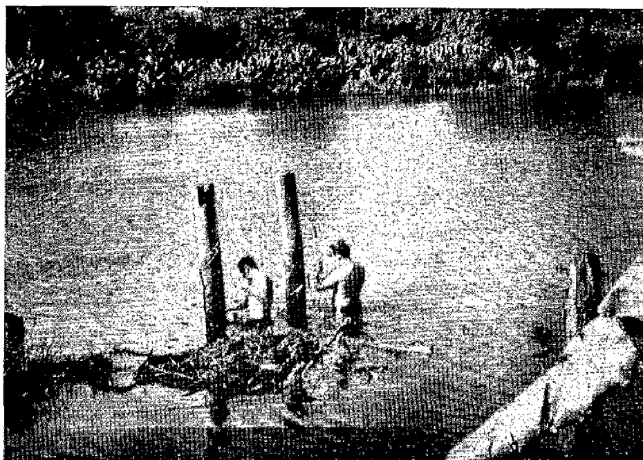
Examen de pilotis attaqués par des tarels.
