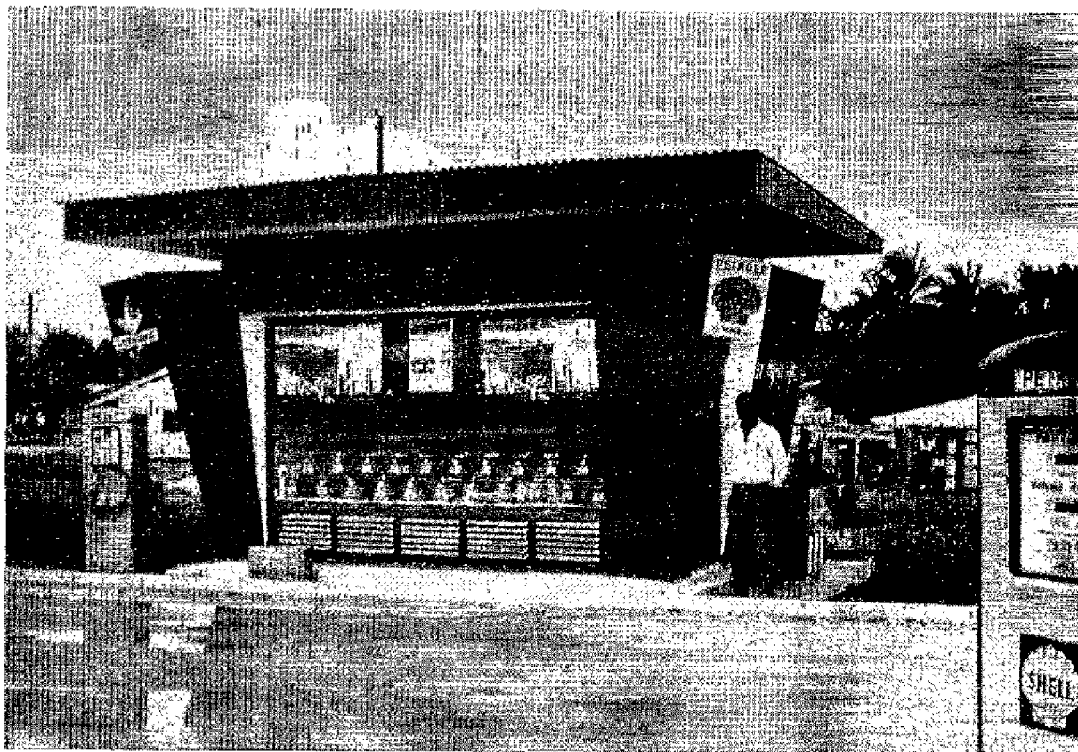
Poste à essence au Gabon.
