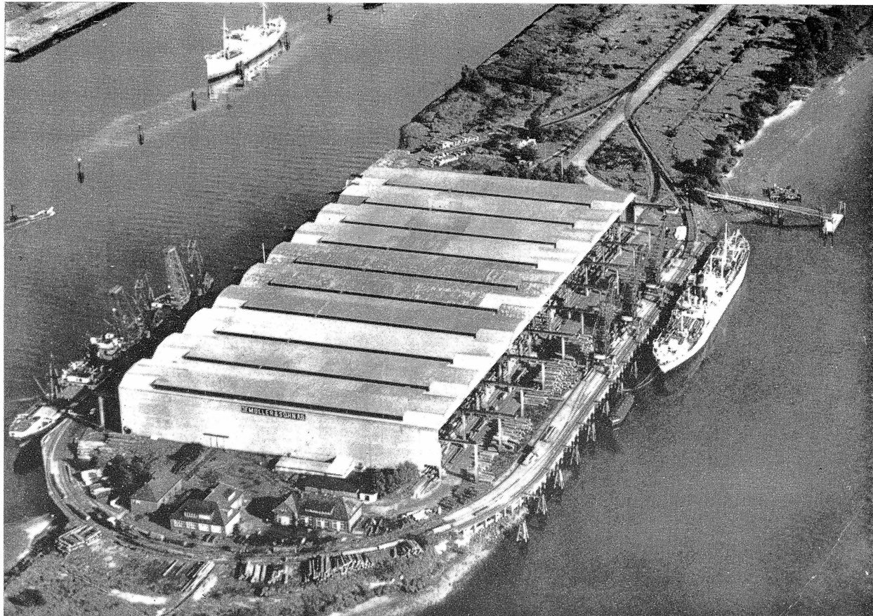
Installation portuaire de la Société J. F. Muller et Sohn A. G. à Hamburg-Waltershof.
