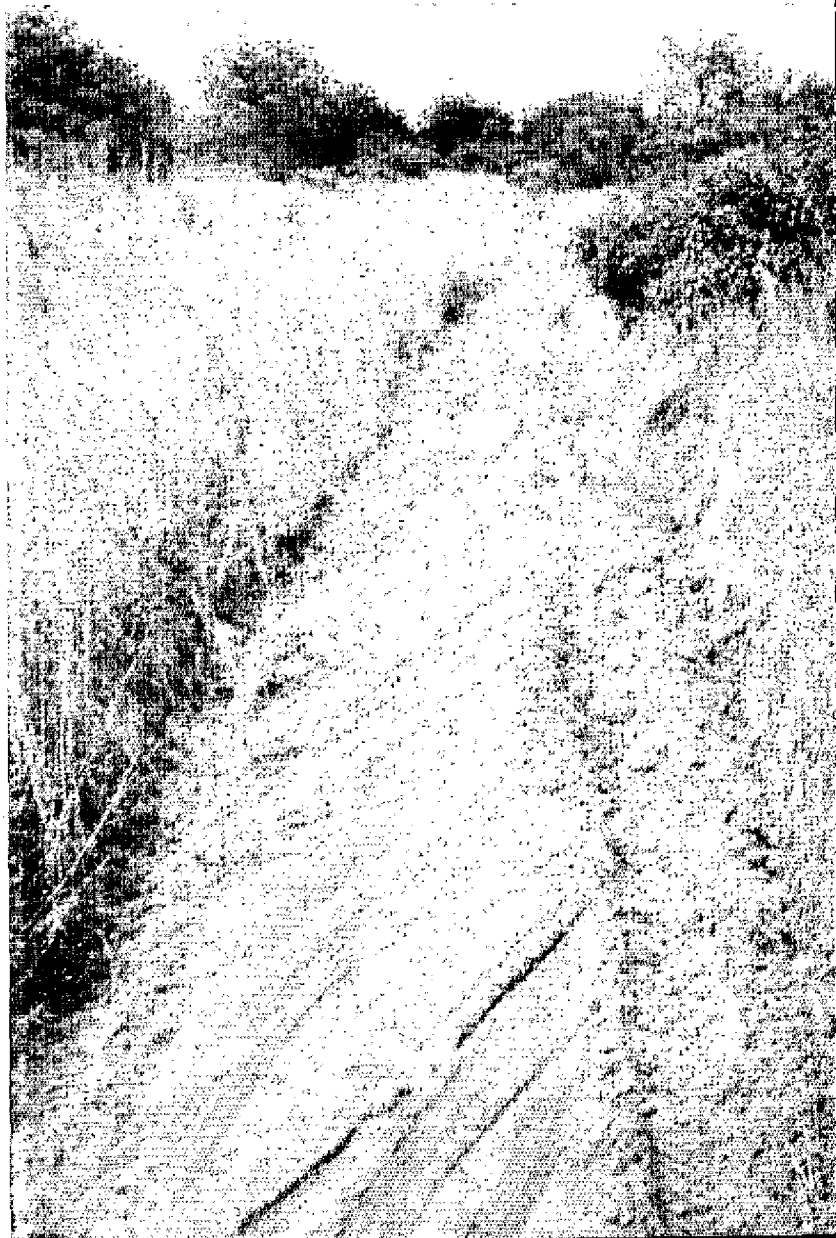
Etablissement d'un pare-feu simple au grader, 1 er passage après dessouchage à la main.
