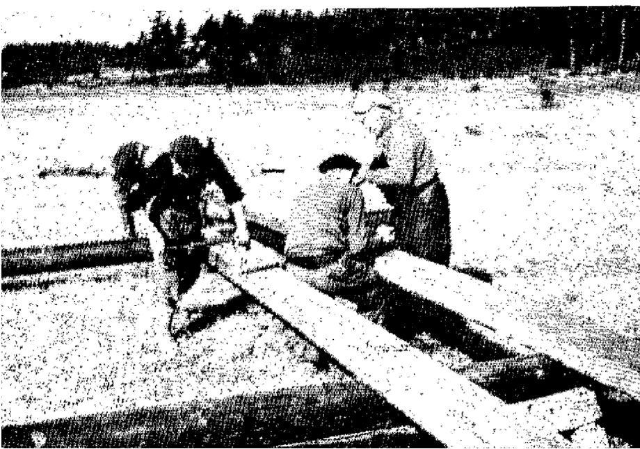
étudiées : des trous largement ovalisés permettent de les adapter sans difficulté malgré d'assez grandes variations dans le diamètre des poteaux. Les boulons très forts, ont un rôle de serrage, mais ne travaillent pas à cisaillement. Les ferrures supportant les chaînes d'isolateurs transmettent toute la charge en appui sur le dessus de la poutre moisée et parfaitement dans l'axe de cette poutre.
