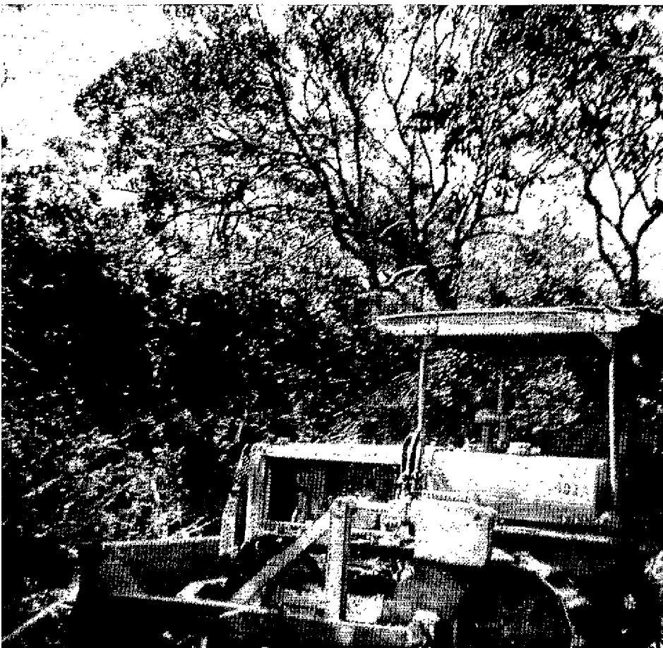
Défrichement au bulldozer d'une végétation arbustive.
