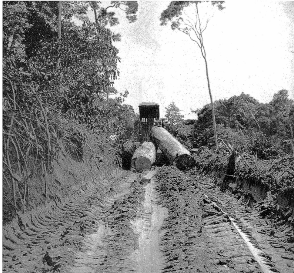
Piste de tirage ouverte sommairement au bulldozer.
