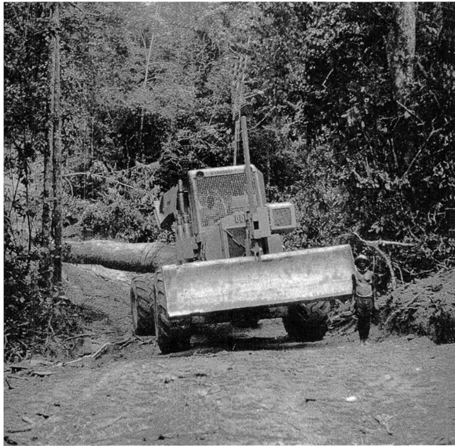
Piste de tirage en saison sèche : sol décapé, nivellement sommaire, pas d'éclaircissement latéral.
