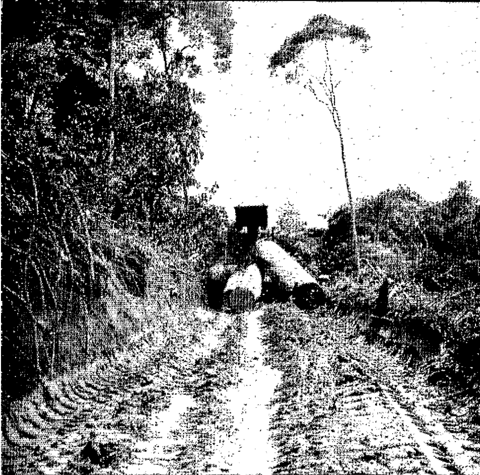
Piste de tirage ouverte sommairement au bulldozer.
