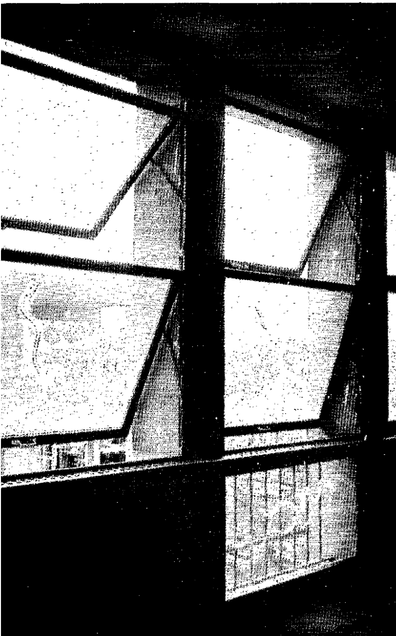
Marseille, Lycée Nord. Fenêtres à l'australienne en Sipo.
