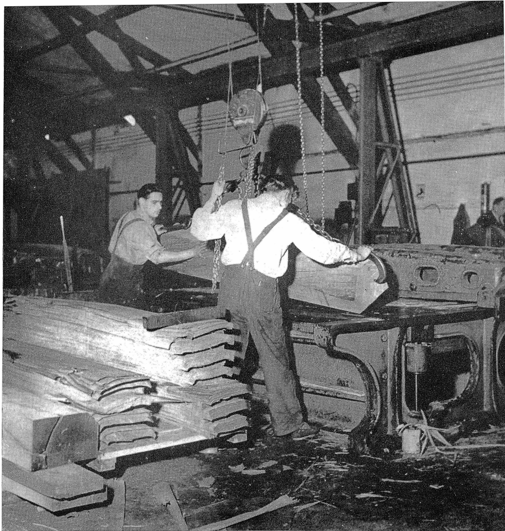
Photo Compagnie Française d'Éditions. Mise en place d'une coutelle sur une trancheuse.
