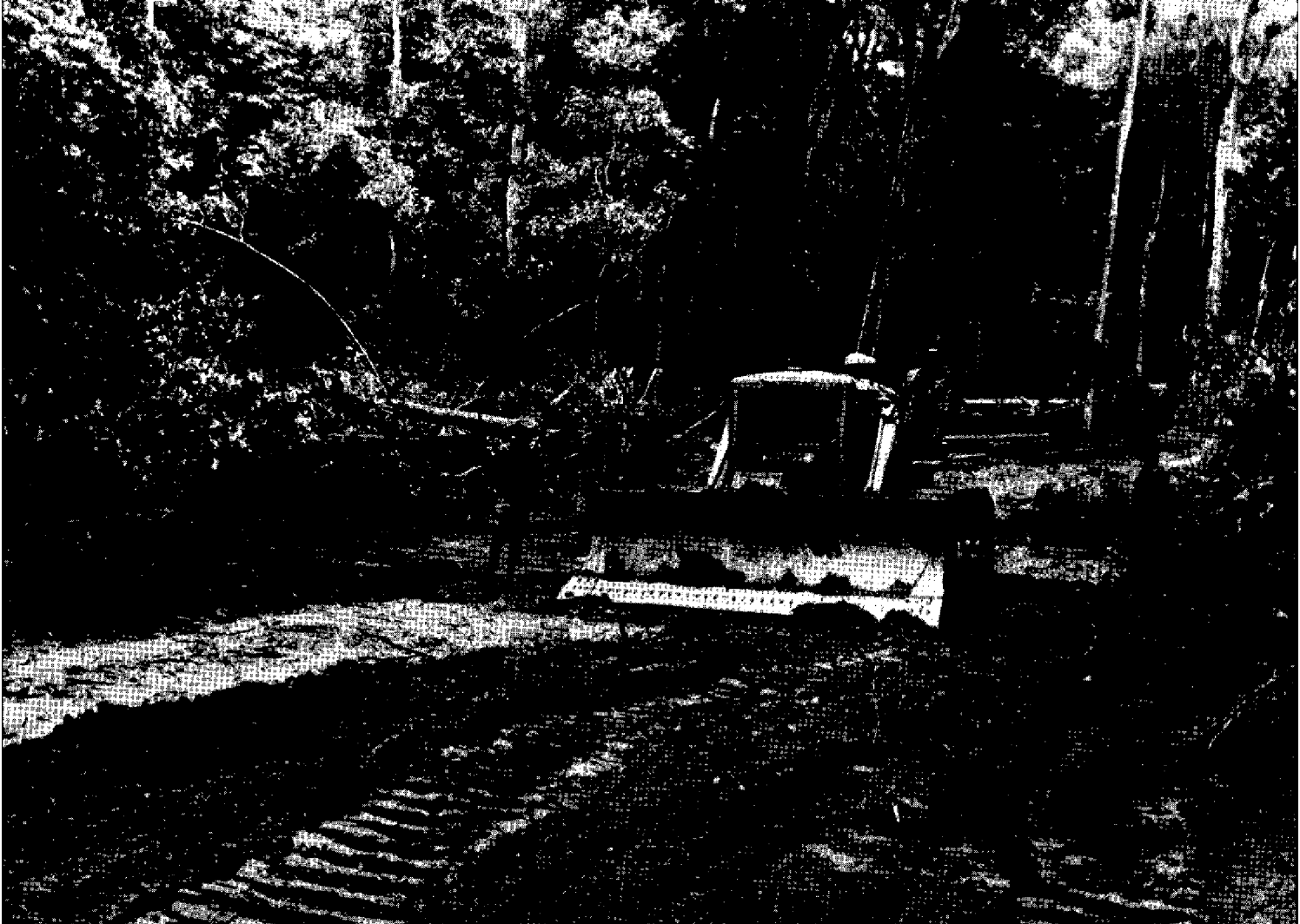
Deuxième passage du bulldozer effectuant le terrassement.
