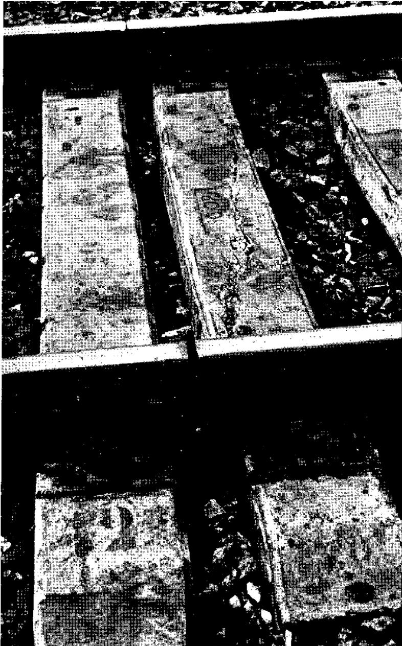
*Traverse précontrainte monolithe, rompue par torsion (détérioration fréquente) quand le ballastage est mal fait ce qui est presque général en voie métrique.*
