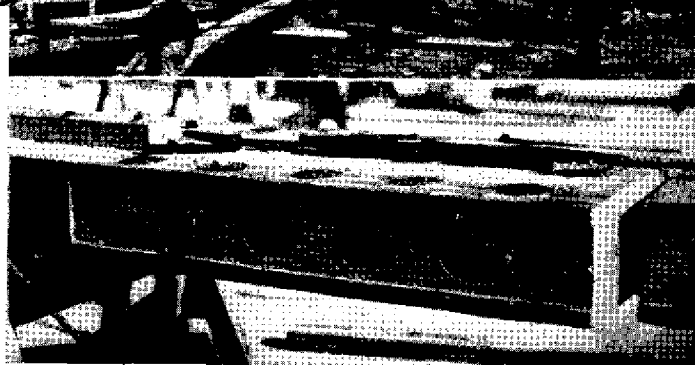
Charpente américaine en arcs lamellés collés, 20 mètres de portée.
