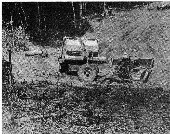
Le scraper se vide en construisant son remblai (Photos C.F.F.)
