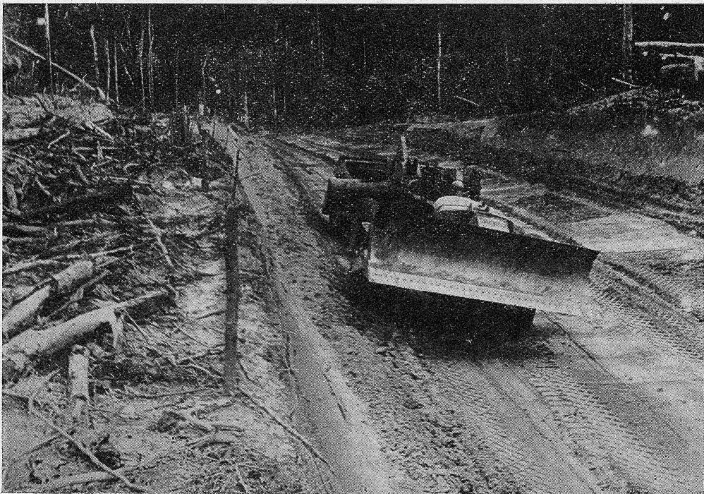
Travail mécanisé : le chantier est vide
