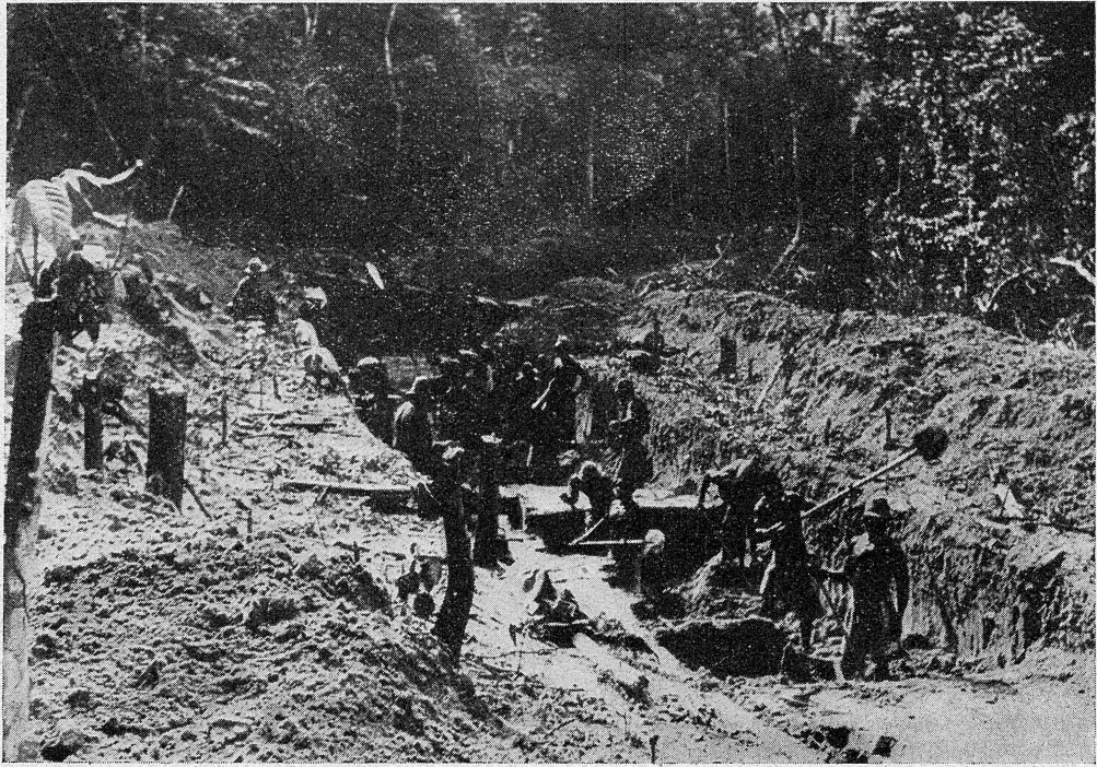
Ouverture d'une tranchée à la main : fourmillère au travail
