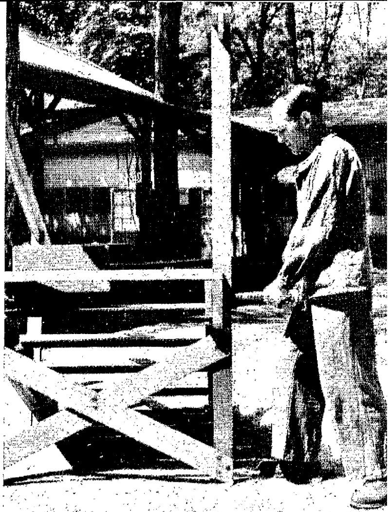
Clouage horizontal au « Marteau-Eclair »
