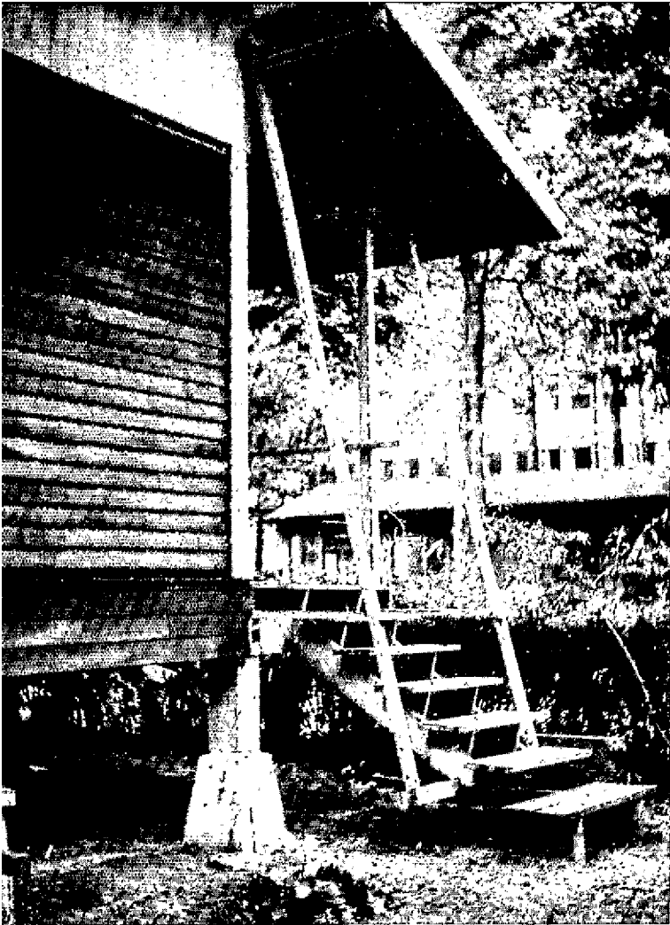
Escalier suspendu : la première marche seule repose sur le sol ; la seconde marche est séparée du sol par un intervalle de 30 centimètres
