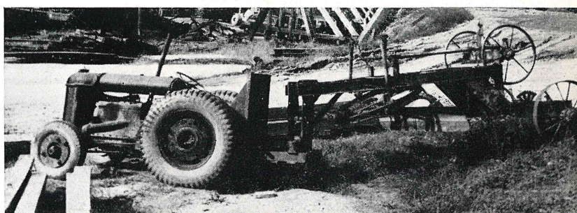
Un grader pour travaux légers, utilisé derrière un tracteur à roues dans une entreprise forestière à Knoxville (Etats-Unis)
