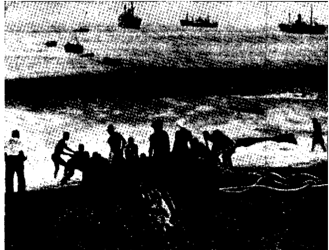
A droite : Les billes sont tirées par un câble jusqu'à un boat mouillé au delà de la barre. Au large, cargos attendant le chargement
