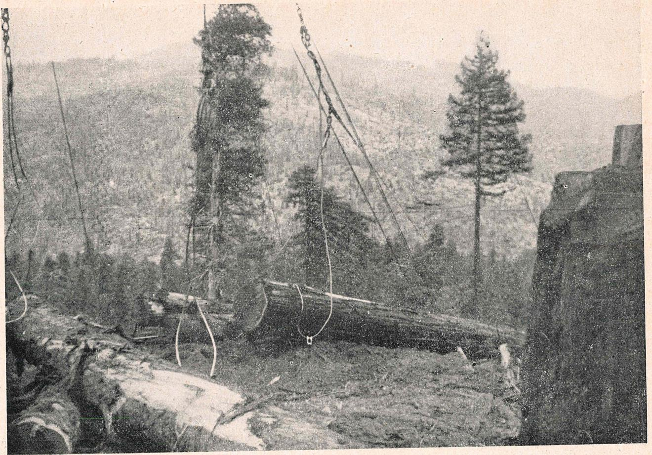
PHOTO N° 5. — Halage de grumes de Sequoia au câble (on voit nettement un crochet « Bardon » enfilé sur le câble).
