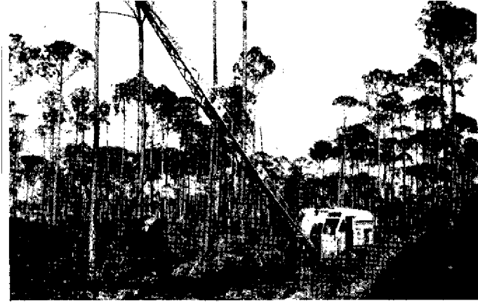
Exécution d'un remblai à la « drag line » ; main-d'œuvre : un seul homme
