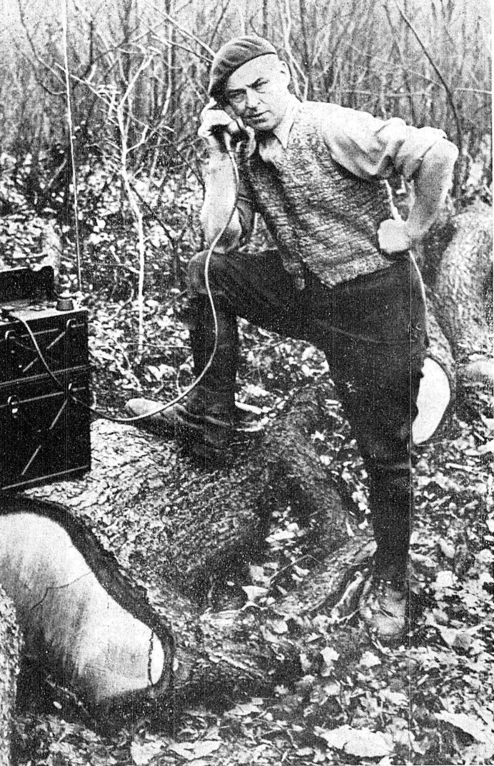
Fig. 12. — Emetteur-récepteur S.C.R. 300 mis en station
