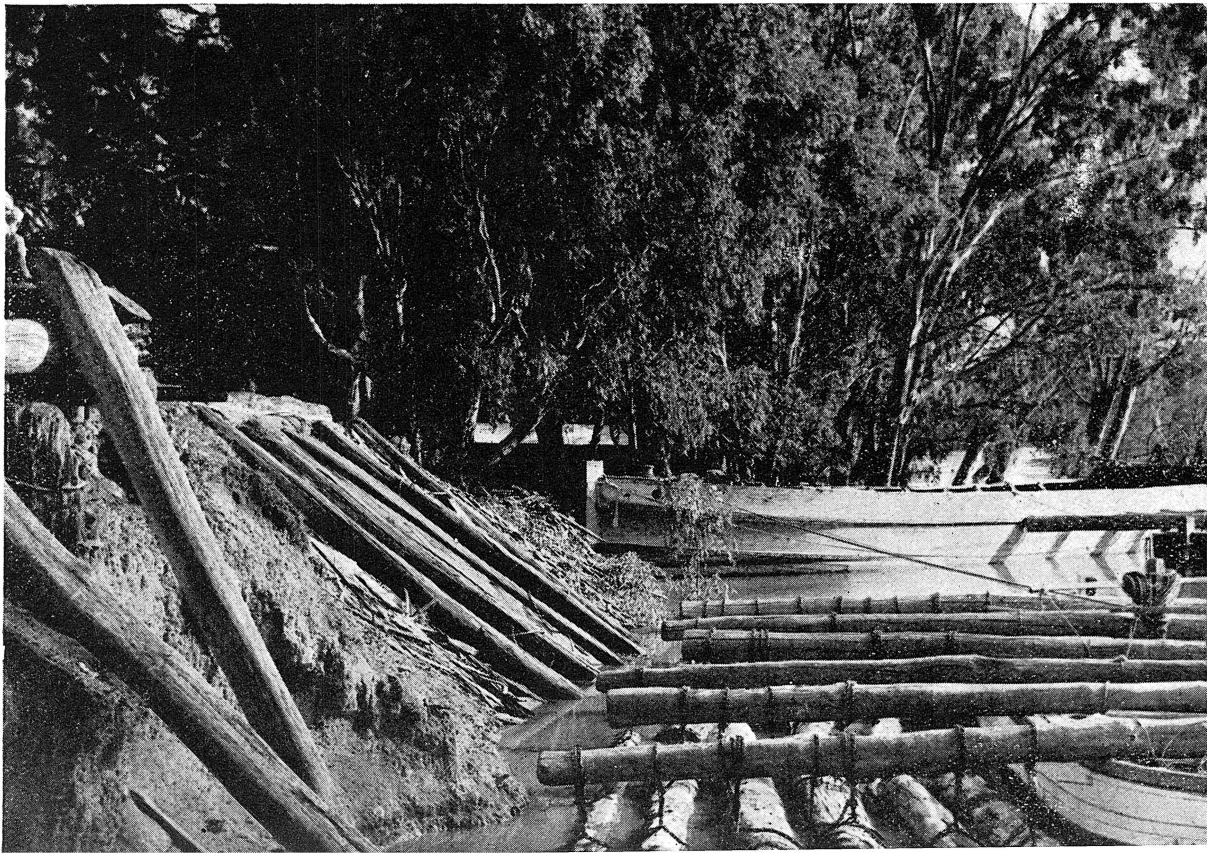
Logs seen beside the ramp at Echuca mill. Grumes devant la rampe de la scierie d'Echuca.
