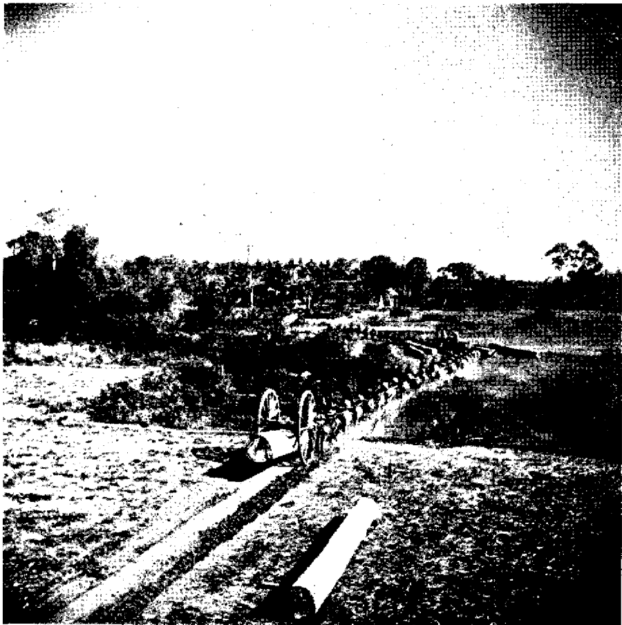
Evacuation par Tri- queballe (Photos C.N.B.T.).
