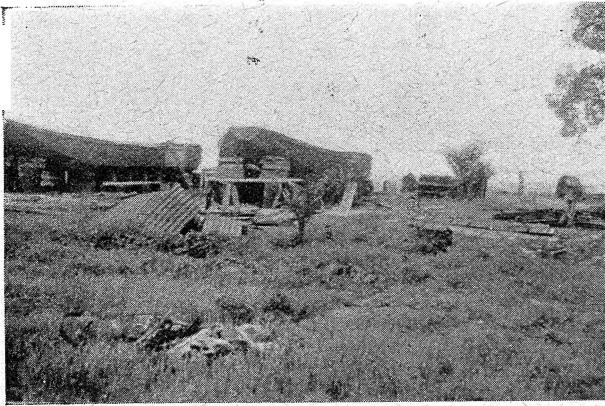
Deux chalands de 30 tonnes en cours d'assemblage
