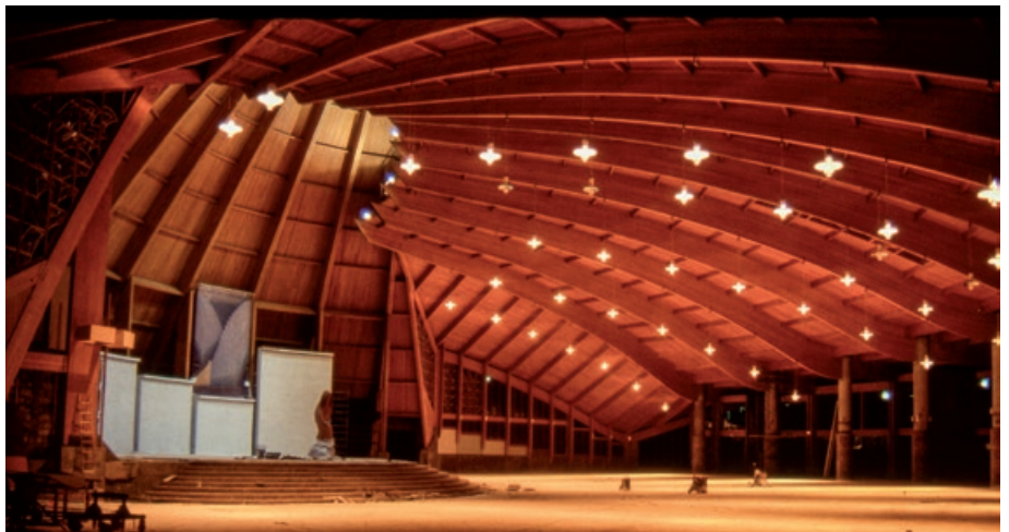
Structure intérieure en lamellé-collé du sanctuaire marial de Mvolye, Yaoundé (Cameroun). Photo J. Uhalde, UBC.
