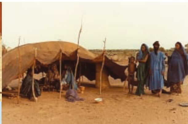
Tente de pasteurs arabes de l'Oudalan faite de peaux d'animaux et soutenue par des poutres en bois. Arab herders' tent in the Udalan region, made of animal skins stretched over wooden timbers. Photo S. Ganaba.
