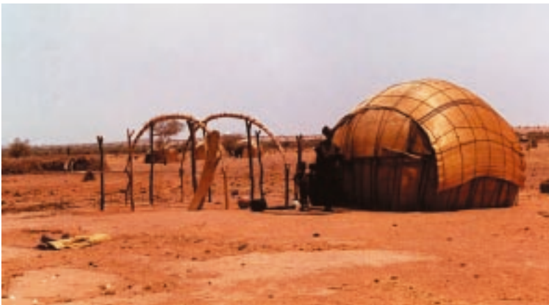
Huttes peules, ou tabarmao (fulfuldé), faites de charpentes de bois et recouvertes de seccos fins décorés. Construites par les femmes, elles sont adaptées aux déplacements saisonniers.
