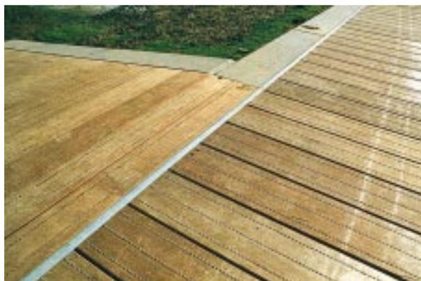
Photo 4. Détail de la jonction entre une rampe d'accès et la zone de circulation en bois, Roubaix (Nord).
